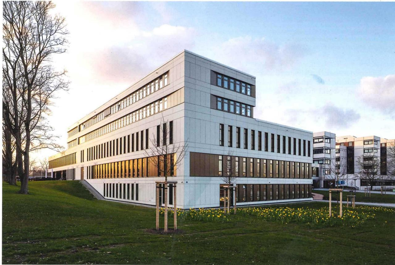
Bild 1. Die Bekleidung aus Zementfaserplatten und pulverbeschichteten Blechpaneelen reagiert auf unterschiedliche Lichtsituationen
